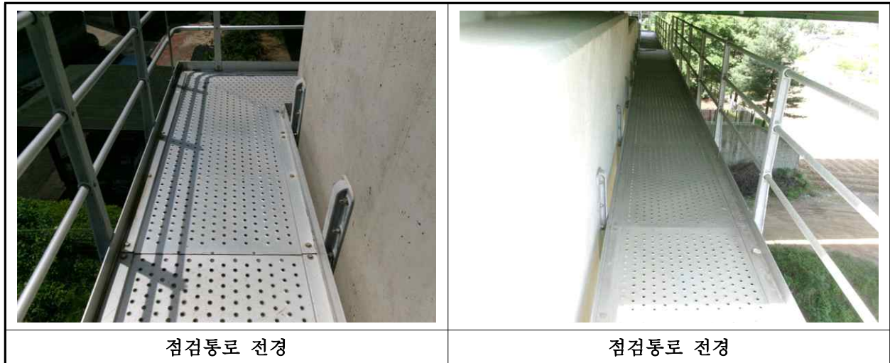
【사진 1.3.25】 교량 점검시설 전경
