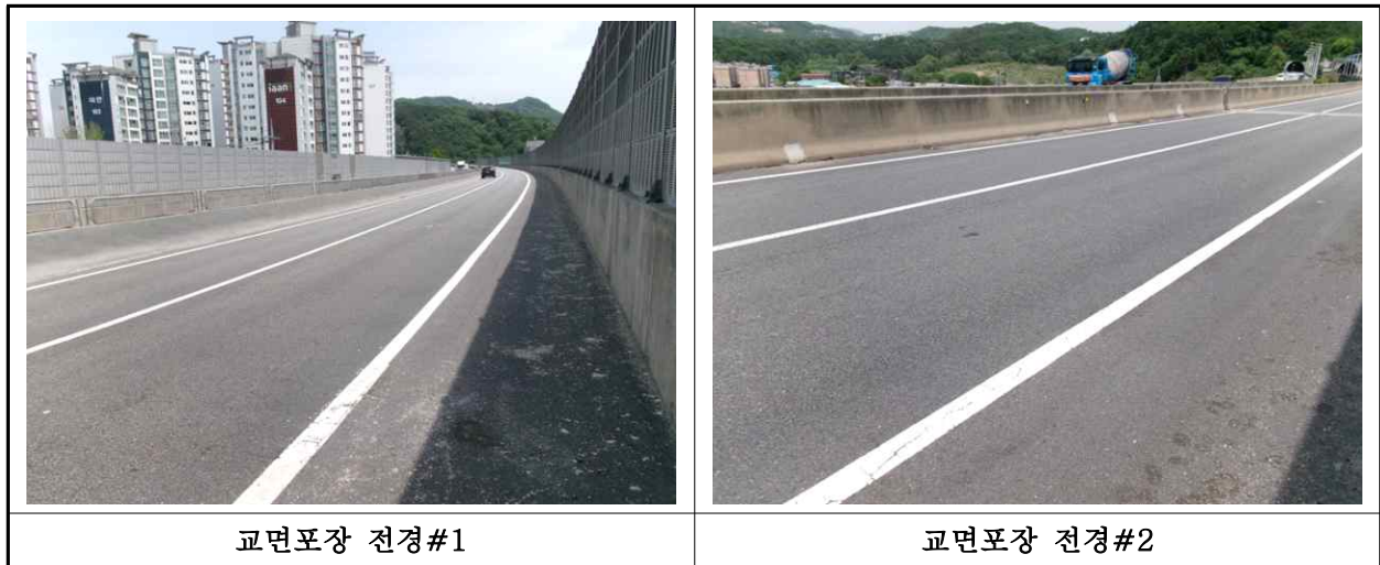
【사진 1.3.19】 교면포장 전경
