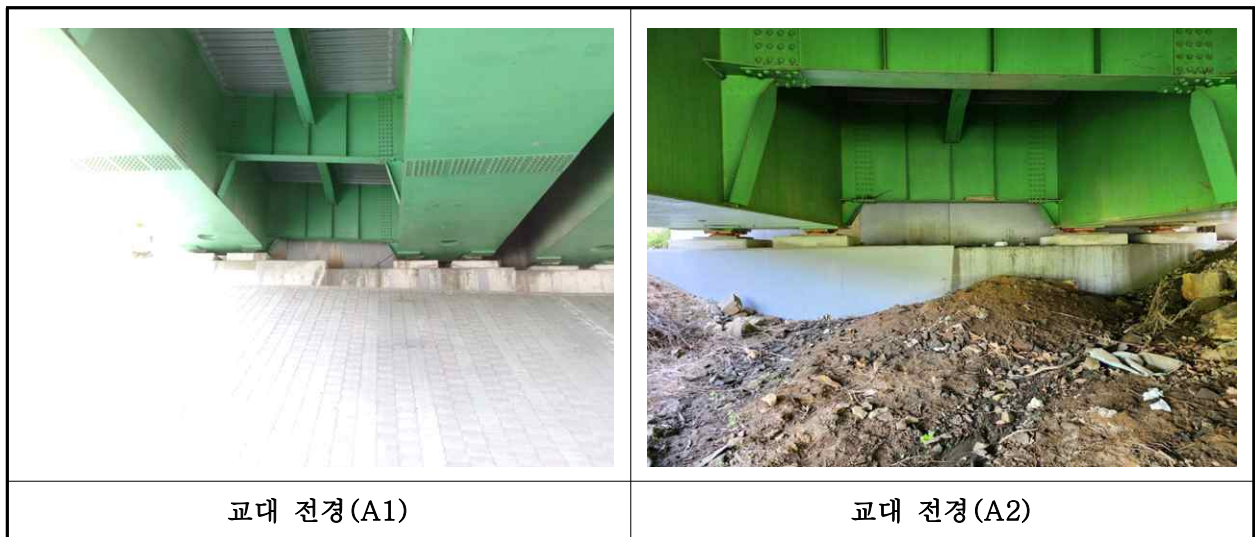
【사진 1.3.8】 교대 전경
