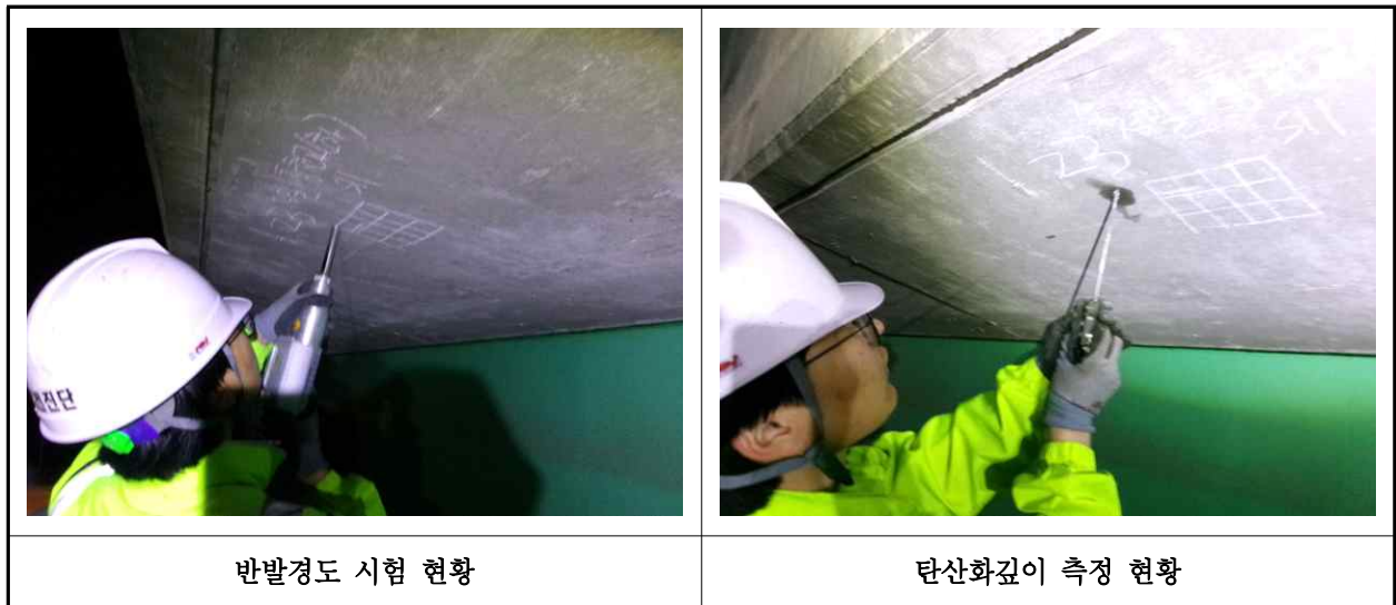
【사진 1.4.1】 콘크리트 내구성조사 현황
