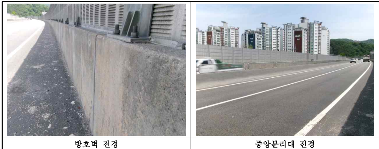
【사진 1.3.23】 방호벽 및 중앙분리대 전경
