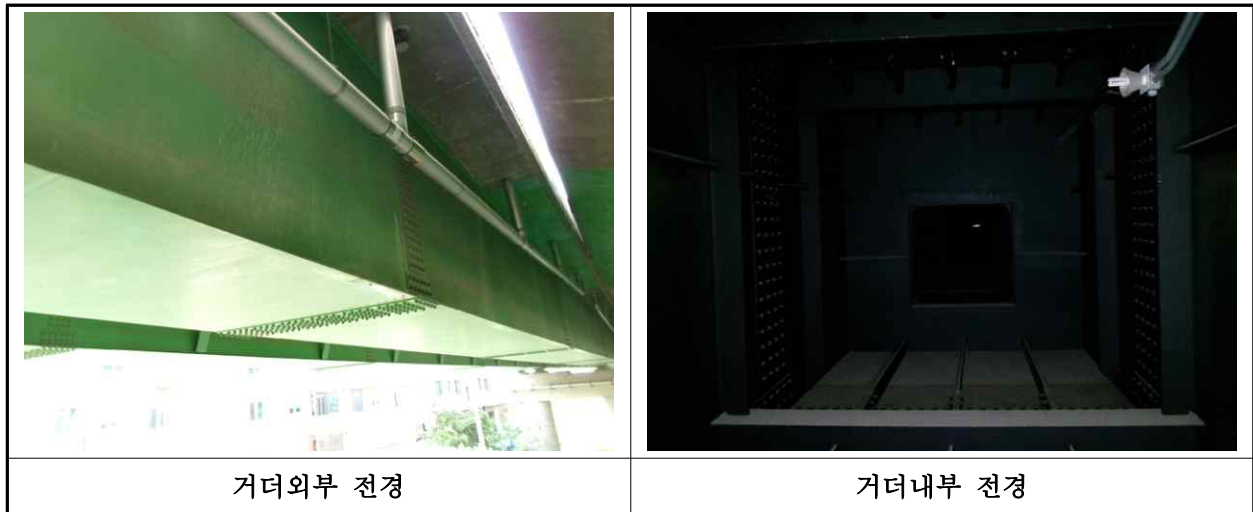
【사진 1.3.4】 거더 전경
