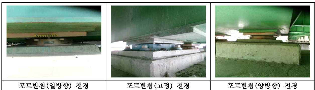
【사진 1.3.12】 교량반침 전경
