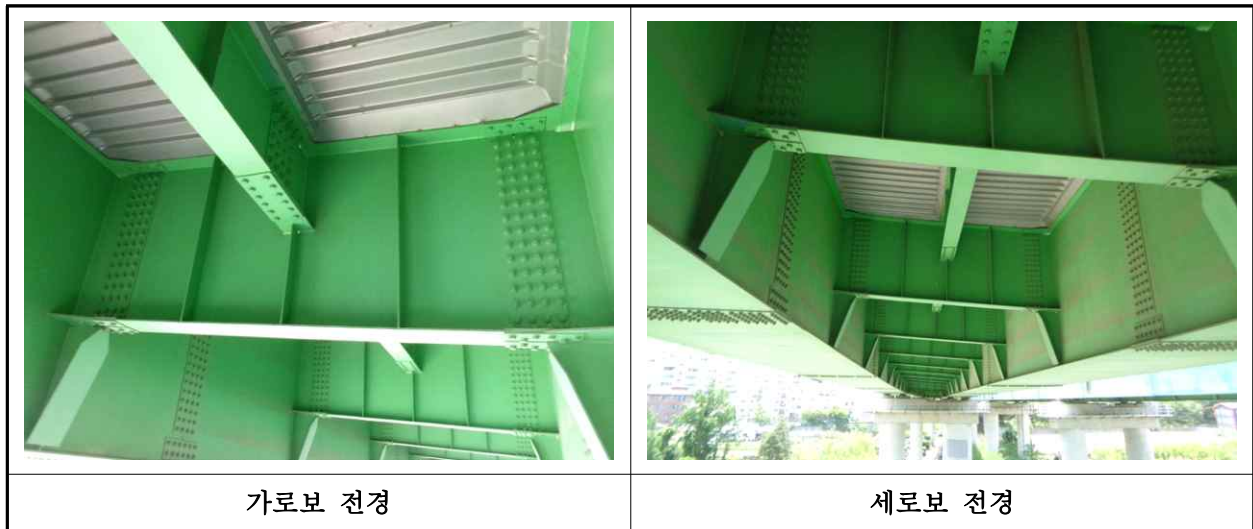
【사진 1.3.6】 가로보 및 세로보 전경
