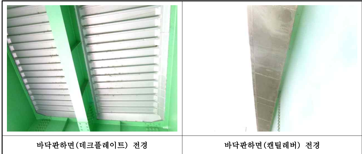
【사진 1.3.2】 바닥판하면 전경
