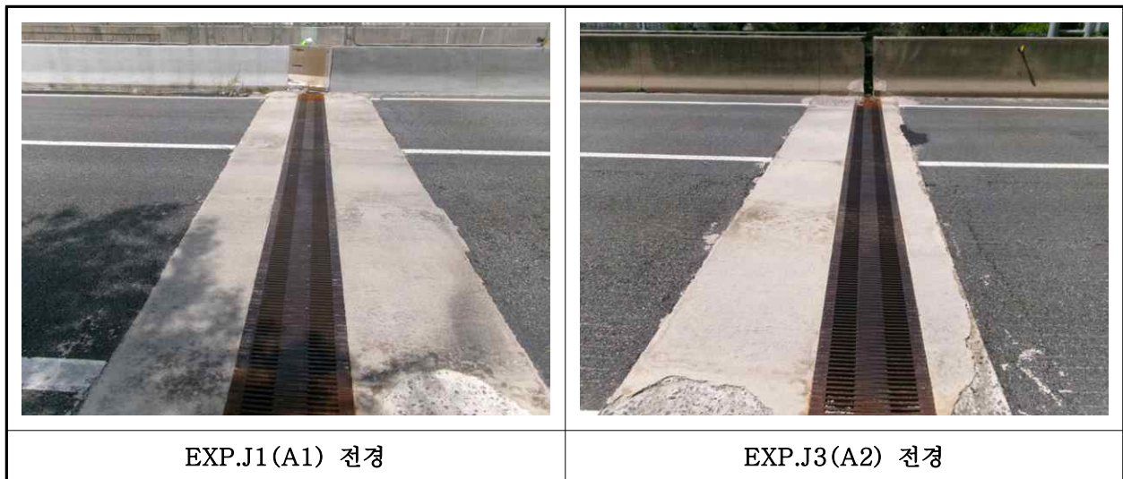
【사진 1.3.16】 신축이음장치 전경
