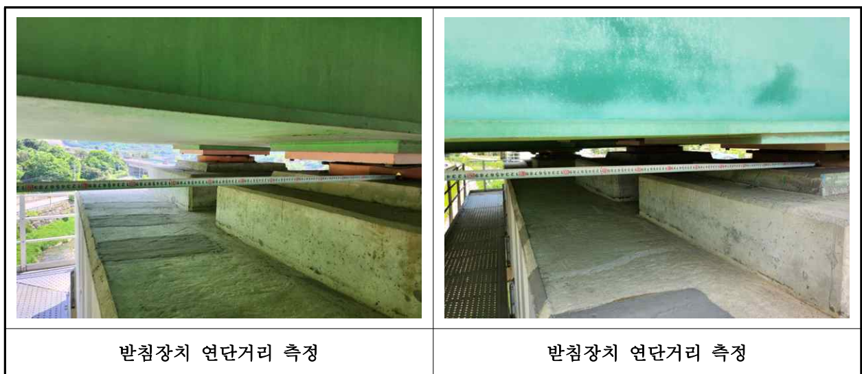
【사진 1.3.14】 교량받침장치 연단거리측정
