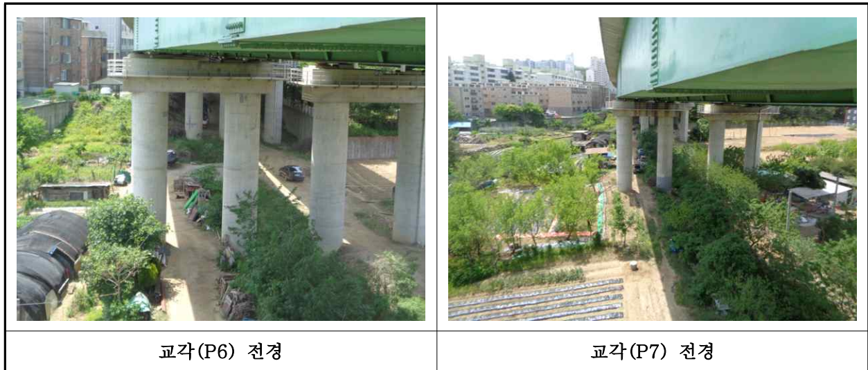
【사진 1.3.10】 교각 전경
